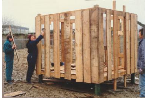
Husbyggeri (jeg lærer at bygge huse! (Nordbuen, Kurt + Ole)
